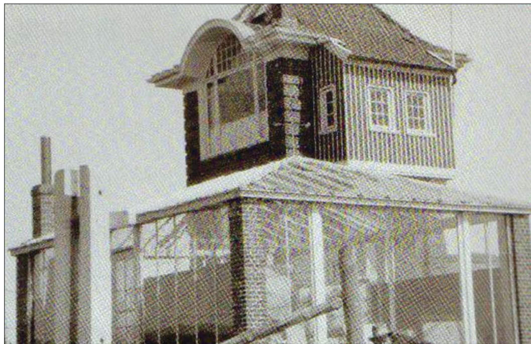
„Malerturm“ mit Atelierhaus – zwischen 1928 und 1940.
