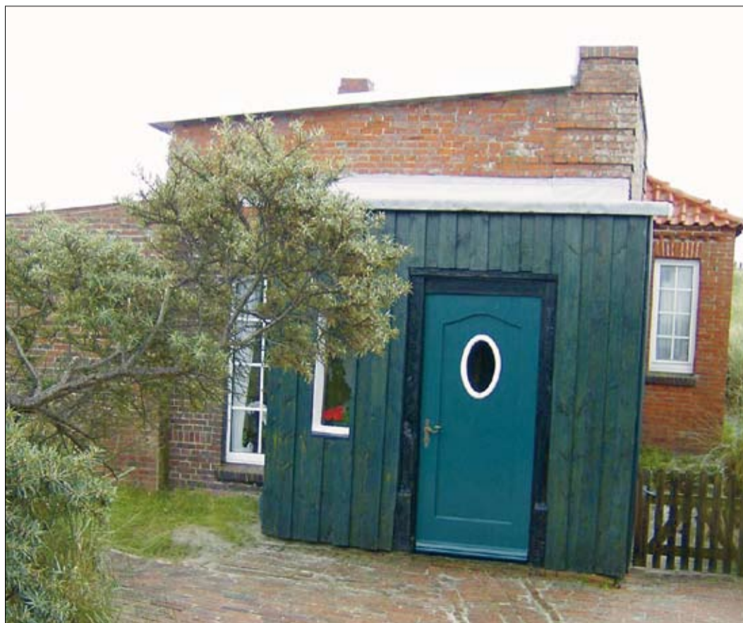
Das ist der derzeitige Zustand: Abgetragener Malerturm mit Wohnung der Familie Folkerts auf Norderney.
